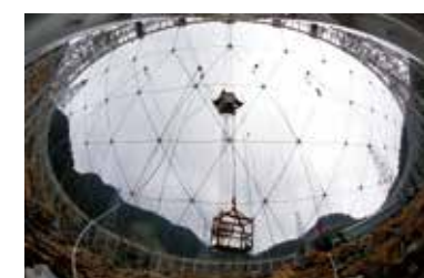
索网结构 Cable-net structure
